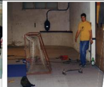
1999 - Bodeneinbau und Hallensanierung in der Reithalle
